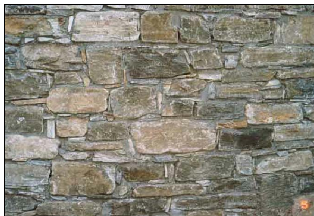
Figura 35: esempio di muro pietra naturale locale (arenaria) e di posizionamento a corsi orizzontali rinvenuta in prossimità del parco della Valletta.
