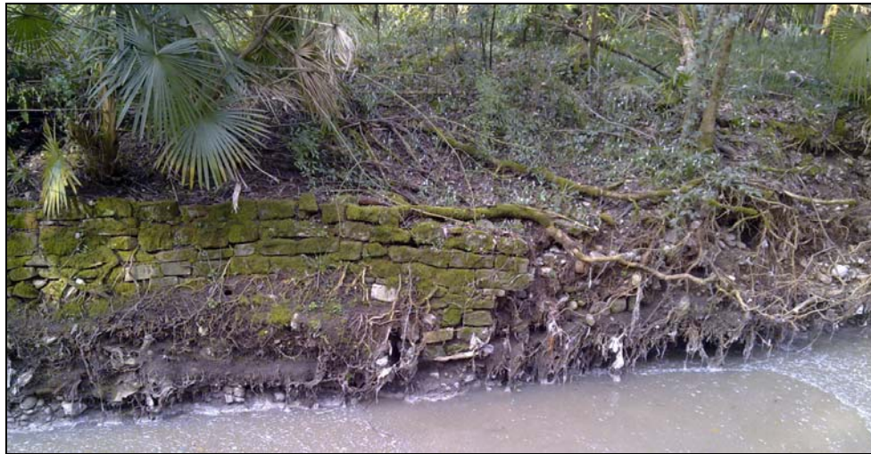
Figura 12: antiche protezioni spondali in pietra, presenti all'interno del parco lungo il Corno.
