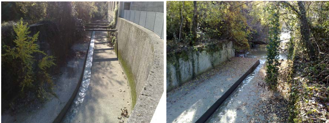
Figura 22 – Il tratto terminale del Corno nell'area industriale, con alveo e sponde cementate, ed a destra la confluenza dello stesso nell'Isonzo.
