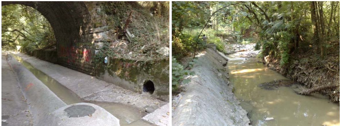
Figura 6 Il tratto intubato dalla Protezione Civile regionale nell'area della valletta ed il termine della stessa tubazione, poco più a valle di viale Oriani. Da qui l'alveo diviene a fondo naturale fino a viale Cristoforo Colombo dove diviene nuovamente tombato.
